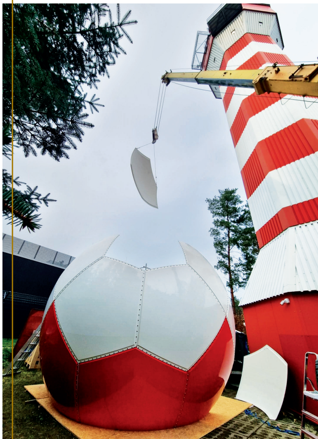
Składanie kopuły radaru w Poznaniu po wymianie urządzeń
